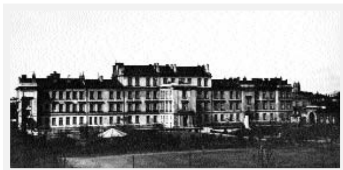
Siedziba Wyższej Szkoły Wojennej w Warszawie od 1923 r.
