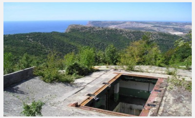
Miejsce startowe jest przykryte grubym kołpakiem z żelazobetonu. Miał wytrzymać eksplozję jądrową.
