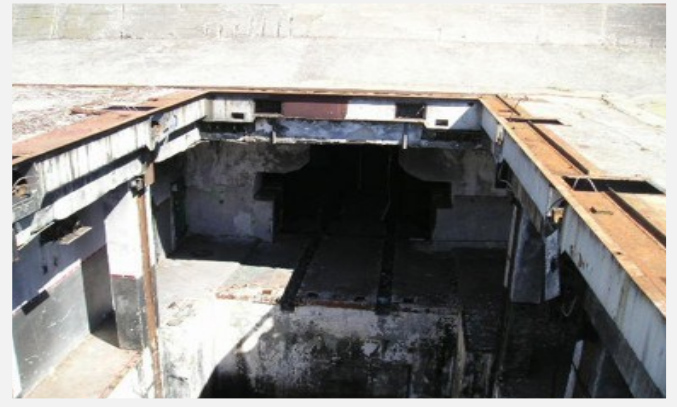
Wyrzutnie chronione masywnymi stalowymi pokrywami, które przy wystrzeleniu rakiety przesunęły się na bok, - teraz przesunęły się na zawsze. Fot. http://www.business-politika.net/sev_foto_100.php
