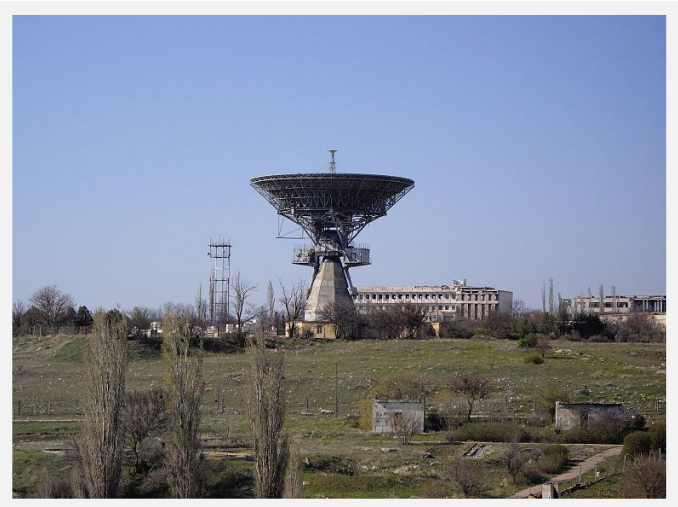
Częściowo zniszczony budynek na terytorium NPP-10.
