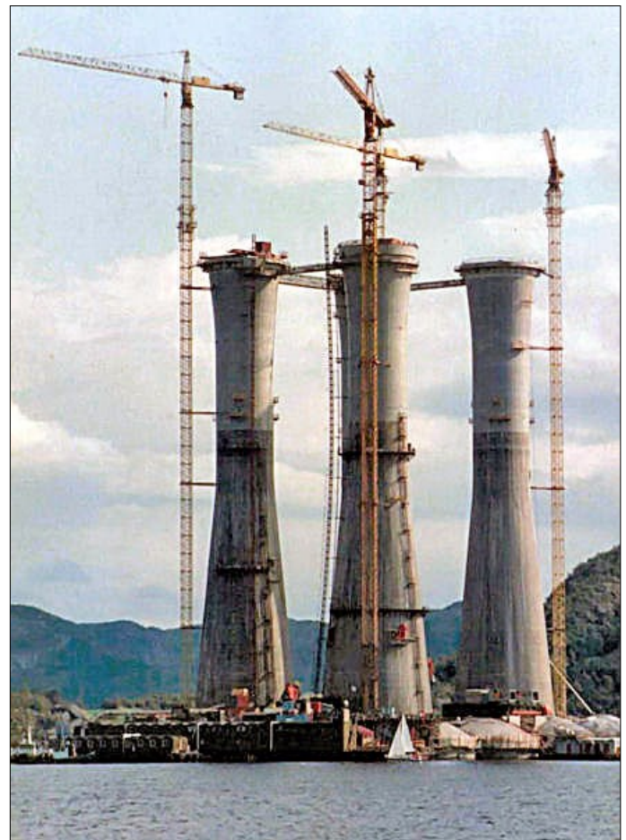
Budowa wieży wiertniczej w Norwegii. Fot. Ranveig / AS990
