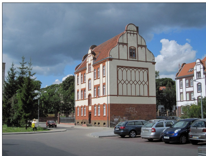
Zespół dawnych koszar piechoty (26 budynków, ul. Wojska Polskiego, k. XIX) w Mrągowie. Fot. GringoPL
