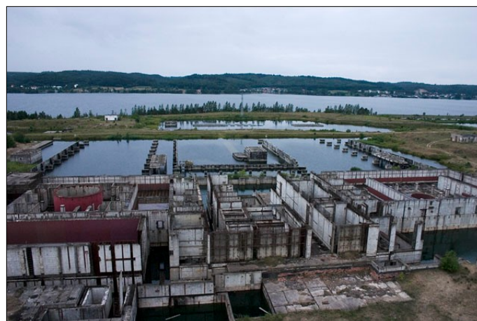
Niedokończona budowa głównego budynku Elektrowni Jądrowej Żarnowiec. Fot. M. Kotas
