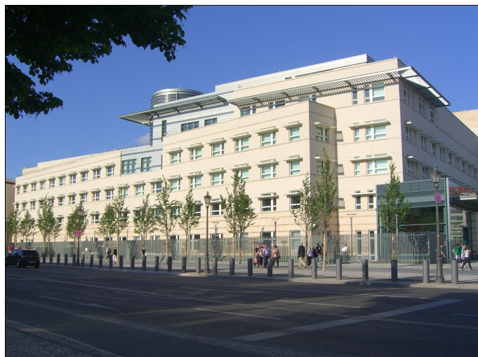
Ambasada Stanów Zjednoczonych w Berlinie – widoczne strefy i bariery ochronne, a także wzmocnione okna. Fot. Times, commons.wikimedia.org
