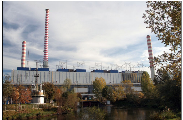
Elektrownia Dolna Odra. Fot. J. Michałowski, commons.wikimedia.org
