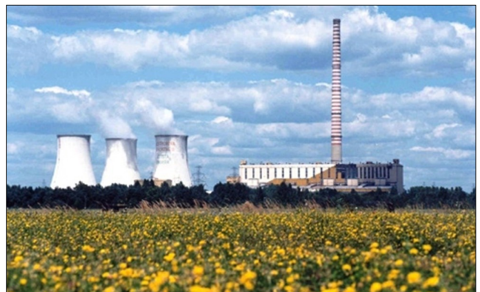
Elektrownia Jaworzno III. Fot. Skyblue, commons.wikimedia.org
