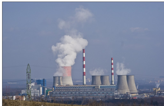
Elektrownia Łagisza. Fot. Arielbedzin, commons.wikimedia.org
