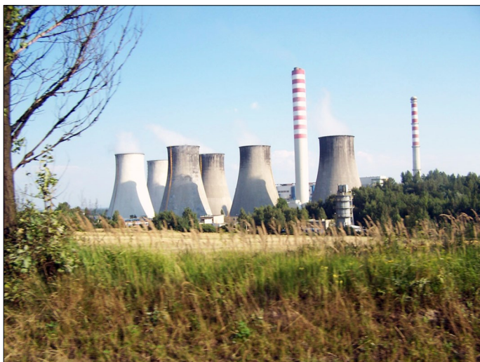
Elektrownia Łaziska. Fot. Piotrus, commons.wikimedia.org
