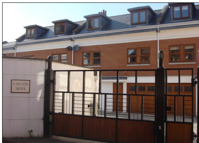
Na zdjęciu widoczny tylko jeden z wielu przykładów tzw. grodzonych osiedli (ang. gated community ), coraz popularniejszej metody mającej czynić osiedla bezpieczniejszymi. Fot. Oxyman, commons.wikimedia.org. Hampstead, Wielka Brytania
