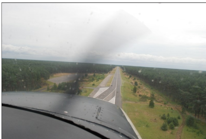
Drogowy Odcinek Lotniskowy Goleniów - Kliniska (droga nr 142). Współrzędne: N53° 25'38.7 E14° 48'20.0 Zobacz miejsce w Google Maps . Fot. www.lotniska.dlapilota.pl
