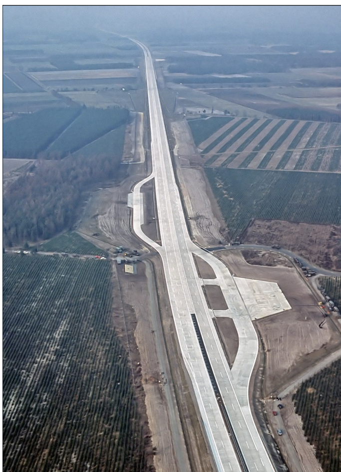
Niemiecka autostrada A29, przygotowana do przyjmowania samolotów podczas ćwiczeń NATO w 1984 roku - Highway 84.
